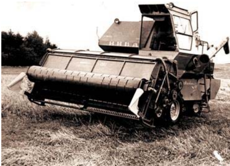
Рис.2. Очесывающая жатка на комбайне СК-5 "Нива" (один из первых образцов).
